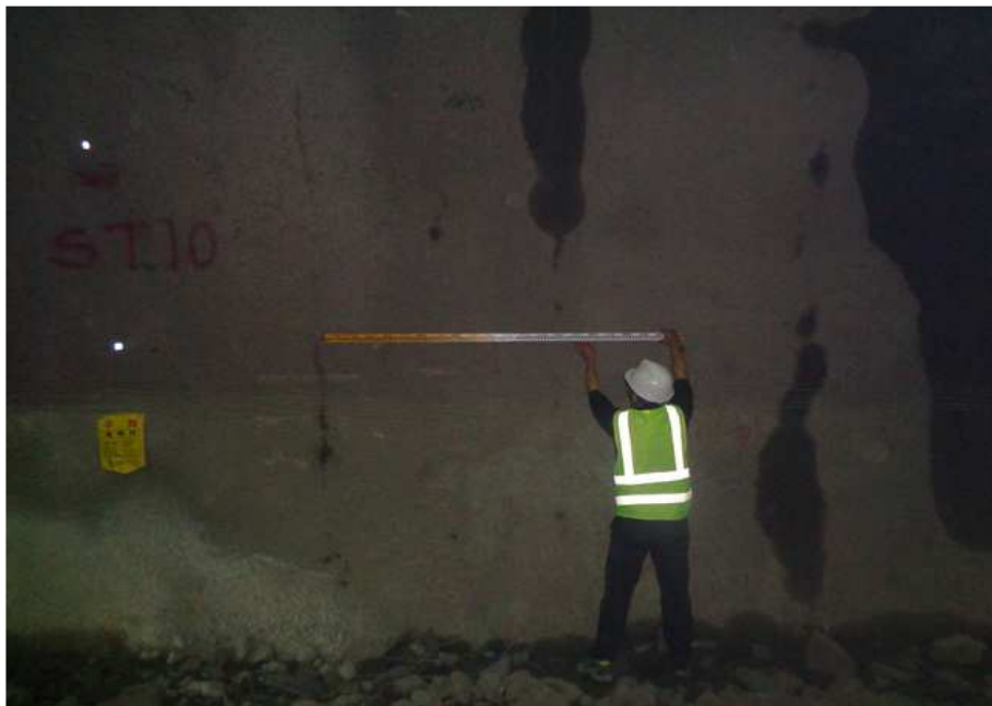
STA 0+610 ~ 0+871 터널 지보공 현황
