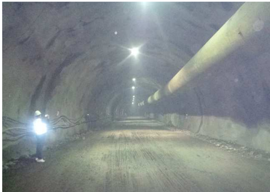
서면2터널 시점부 내부 전경
