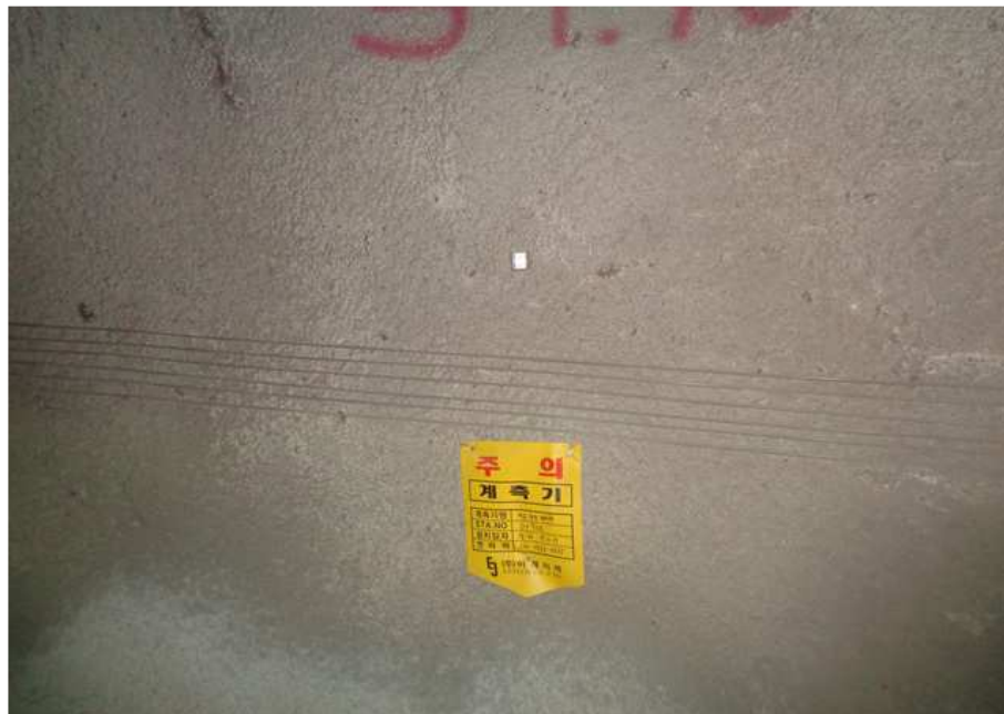
STA 0+610 ~ 0+871 터널 계측 현황
