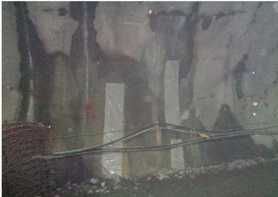
STA 0+610 ~ 0+871 방수공 현황
