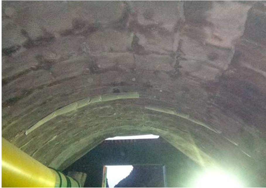
STA 0+610 ~ 0+871 방수공 현황
