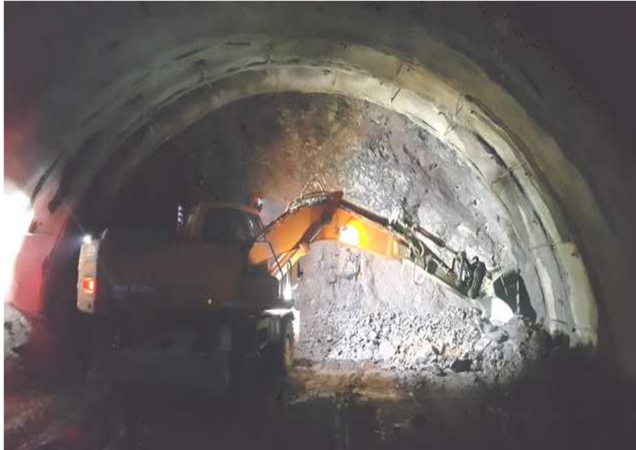
STA 0+610 ~ 0+871 터널 굴착 현황
