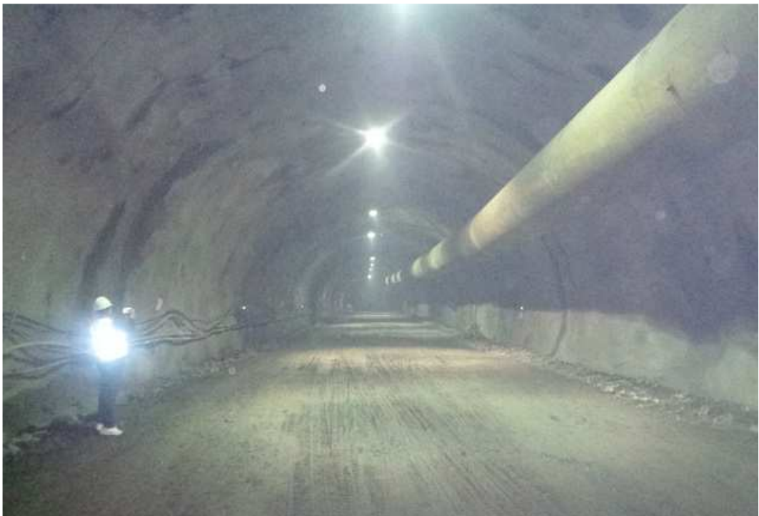
서면2터널 시점부 내부 전경
