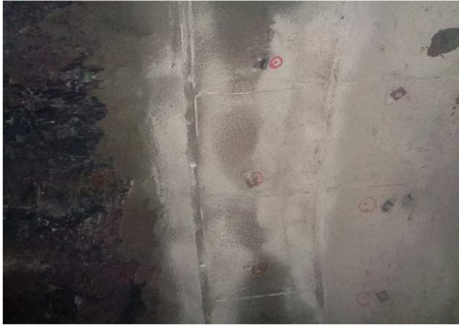
STA 0+610 ~ 0+871 터널 지보공 현황
