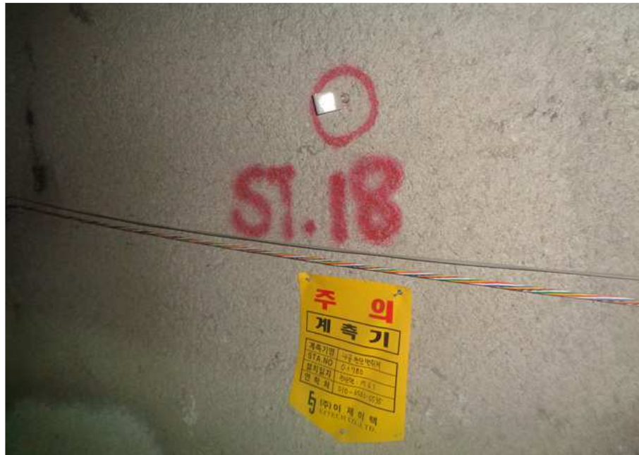
STA 0+610 ~ 0+871 터널 계측 현황
