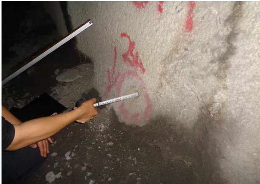
STA 0+610 ~ 0+871 터널 지보공 현황
