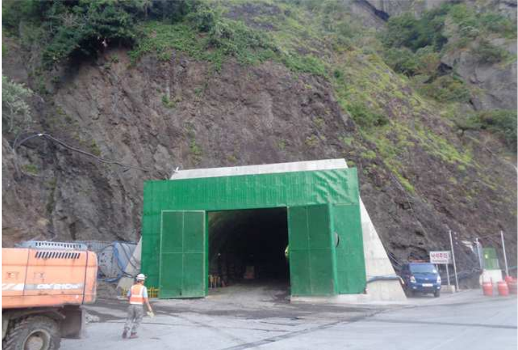
서면2터널 시점부 갱구 전경
