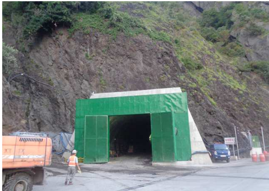
서면2터널 시점부 갱구 전경
