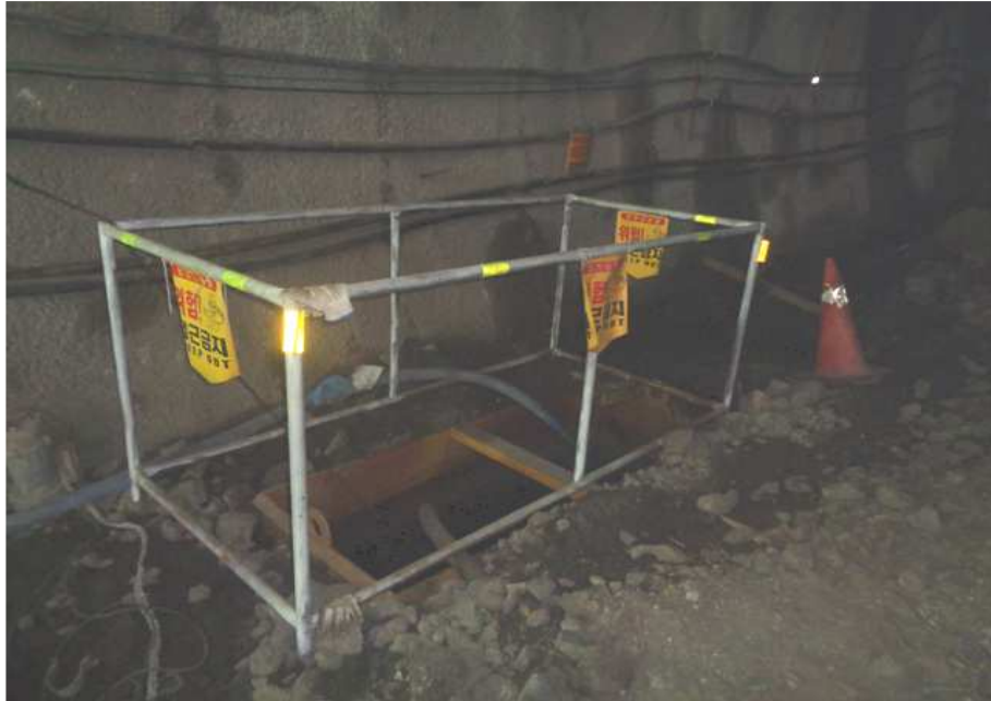
오·폐수 처리시설 전경
